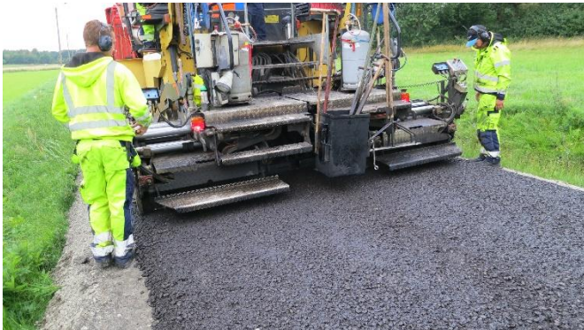
Figur 5 - Utläggning fullskaleförsök
