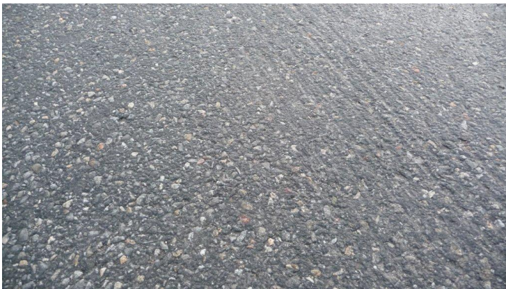
Figur 20 - Överboda, 1998-2012 "16 Ö", Färskt stenmaterial, PEN 330/430. Inget stensläpp, men synliga hyvelskador efter snöröjning
