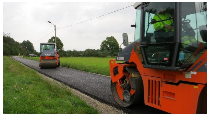
Figur 6 - Packning fullskaleförsök
